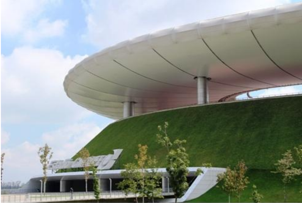
Green roof at the Estadio Omnilife (Zapopan, Zona Metropolitana de Guadalajara, México) / Francesca Olivieri.
