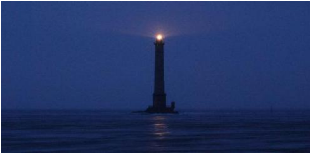
La Hague lighthouse. Credit: Wiki Commons
